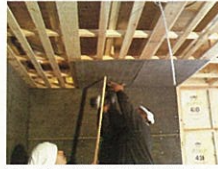
④目地及びビス頭にタイバテープを貼り、パテ処理。
