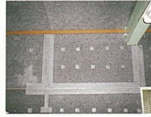
③ボード貼付 3mm程度の目地を入れボードを200mmピッチ以下で、ボード用ビスで止める。
