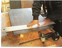
②下地の寸法に合わせてカットナイフ等で切断。
